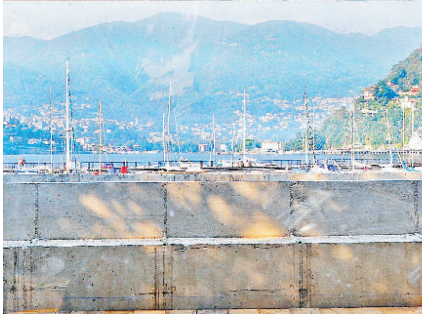
La parete di cemento costruita dal Comune per evitare le esondazioni
